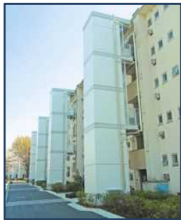
中層住棟へのエレベーター設置
